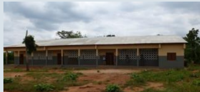
Die fast fertiggestellte Grundschule in Dogbo
