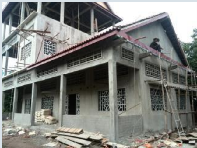
Aktueller Stand der Bauarbeiten in Tropang Sdock
